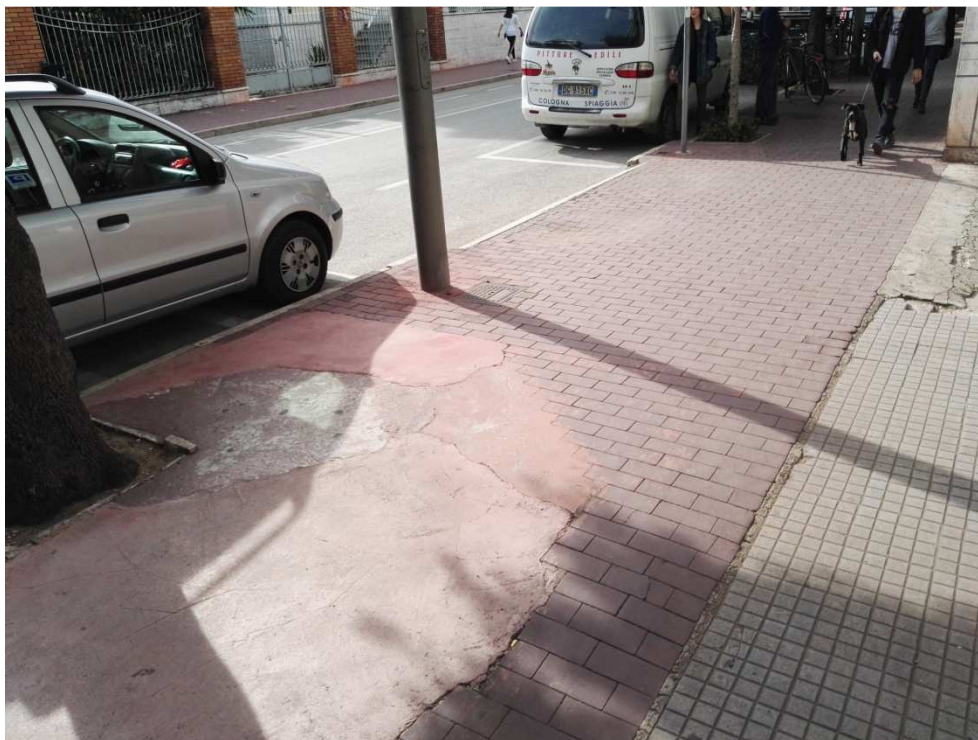
Foto 3 - Via Nazario Sauro tratto est (lato nord) (rottura e degrado pavimentazione, presenza di irregolarità del piano di calpestio)
