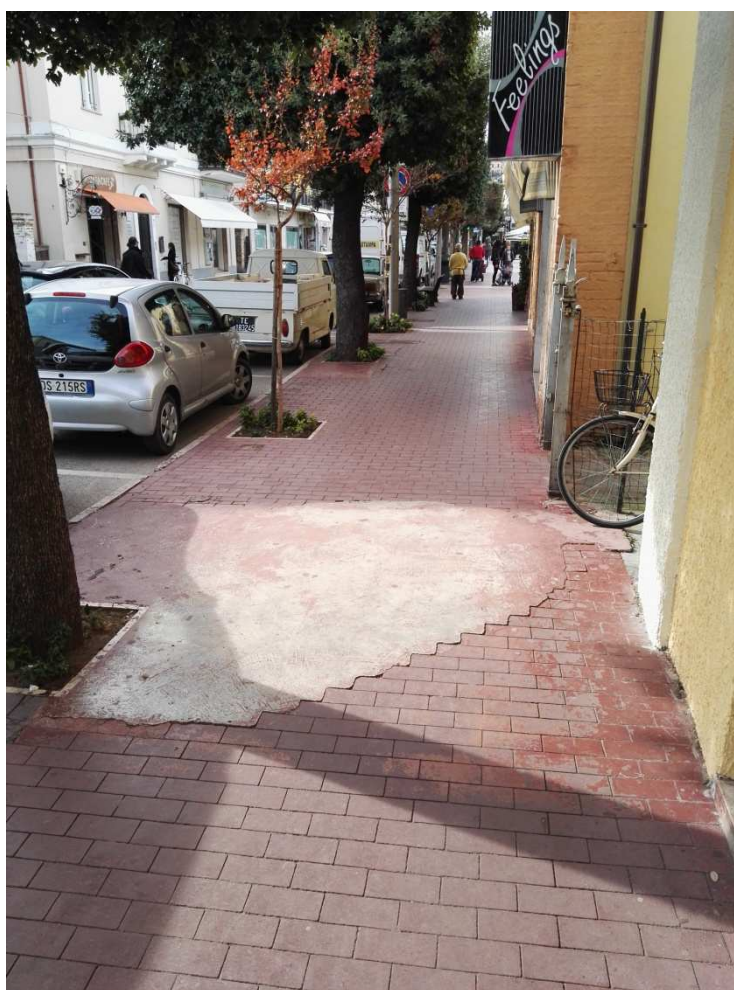
Foto 4 - Via Nazario Sauro tratto est (lato nord) (degrado pavimentazione, presenza di irregolarità del piano di calpestio)
