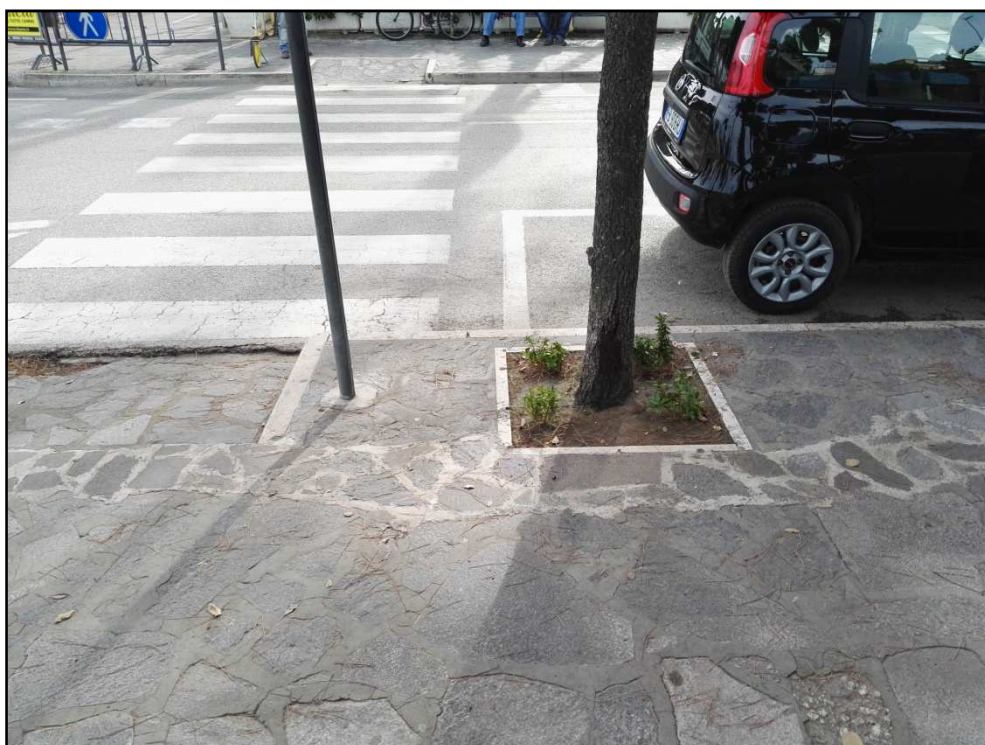
Foto 6 - Via Nazario Sauro tratto est (lato nord) (scivolo non a norma, degrado pavimentazione)
